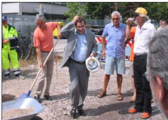
L'ass. regionale Renato Chisso avvia i lavori "Variante 515"
